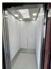
1号館 エレベーター完成!
