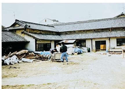
平成20年2月 西納屋解体始まる
